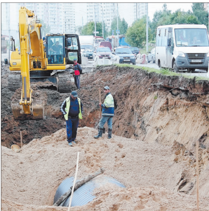
5 июля 2017 г. Перекрёсток улицы Генерала Попова и 3-го Академического проезда. Работы по прокладке новой ливнёвки, которые стали причиной транспортного коллапса.
